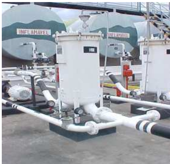
Figura 4: Bombas de sucção e tubulações da instalação de combustíveis de aviação da Base Aérea dos Afonsos - RJ
